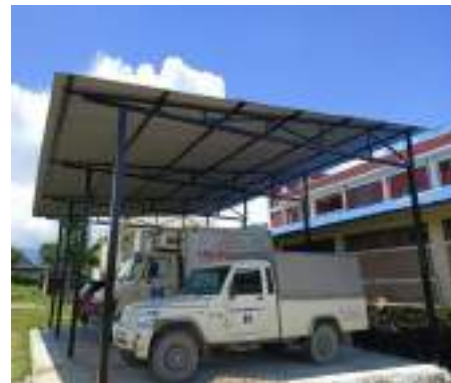
कोल्डरुमको छाना मर्मत तथा ट्रष्ट निर्माण
